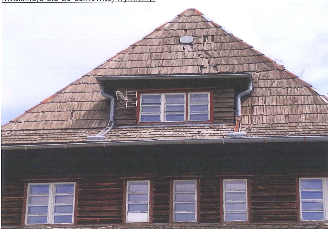
Foto 1 – stan pokrycia dachu szczytowego
