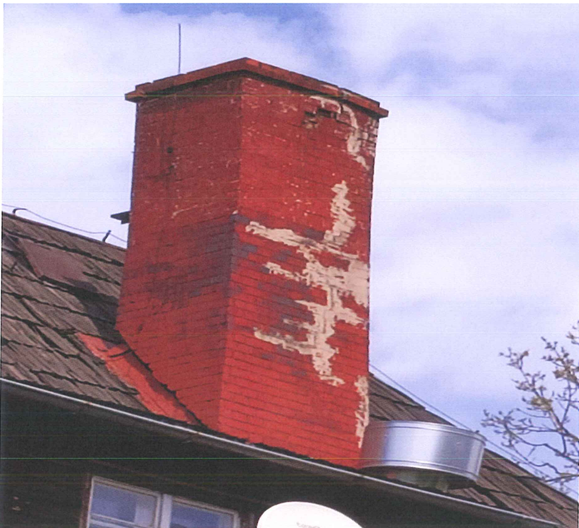
Foto 4 –istniejący komin spalinowy schroniska
